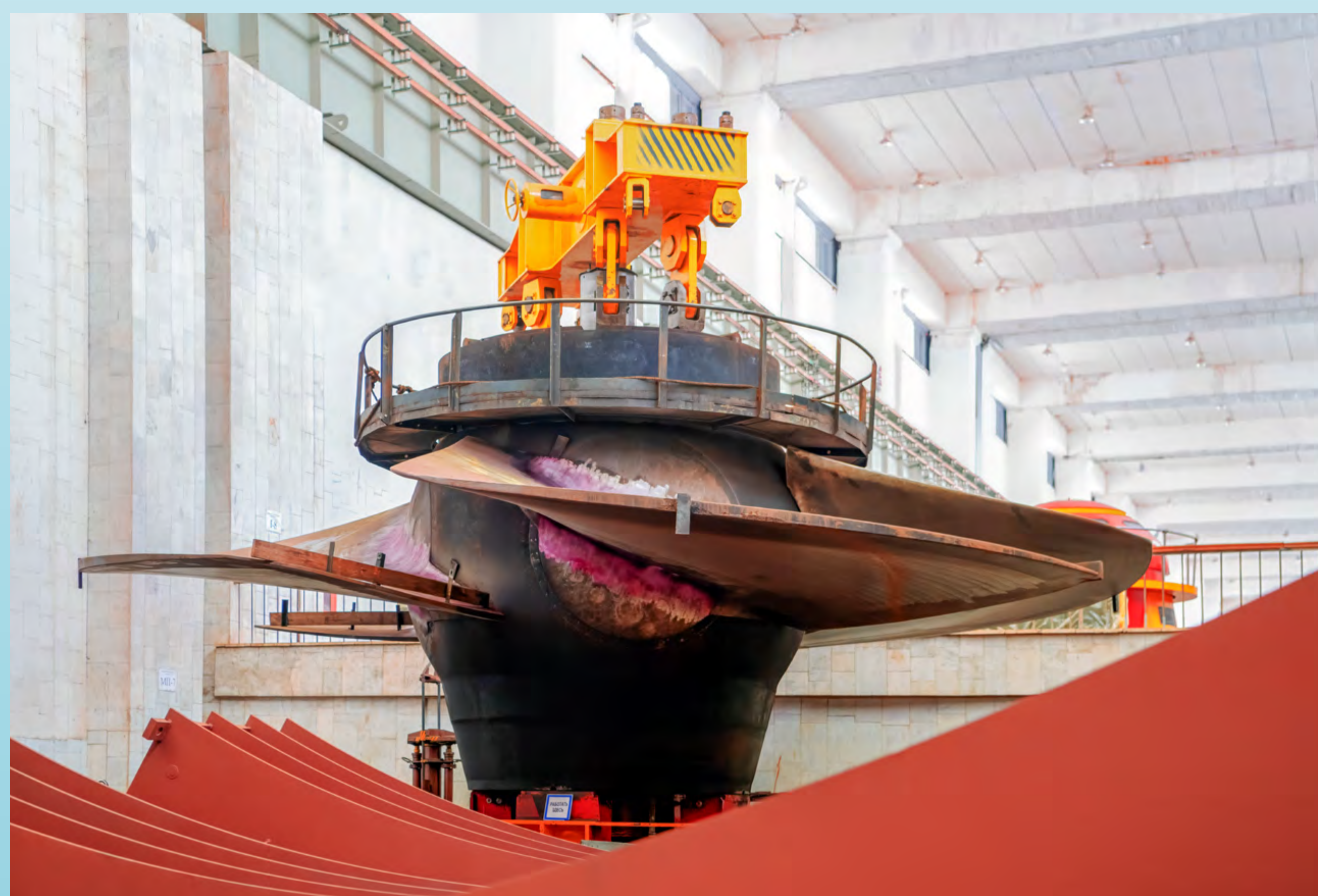
Чебоксарская ГЭС – установка рабочего колеса
